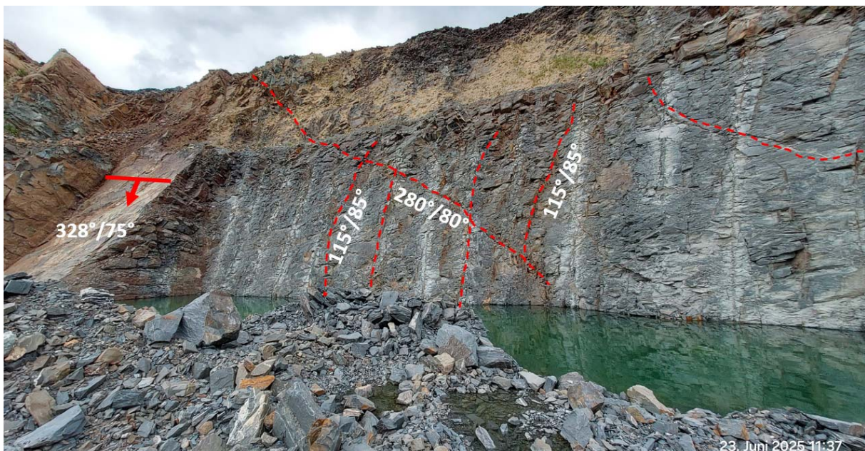
Abb. 13 Störungen bzw. persistente Trennflächen (rot gestrichelt) im Tonschiefer an der Südböschung.
